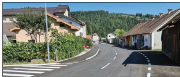
Ureditev cestišča na Prežihovi ulici
