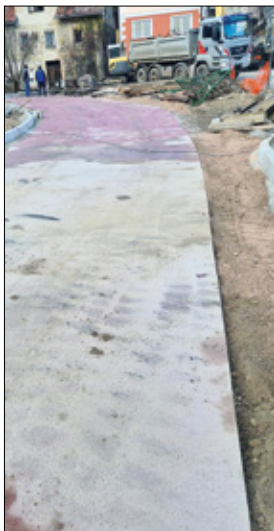
Sanacija krova korita nad Šumcem
