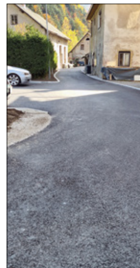
Obnova ceste na Poleni
