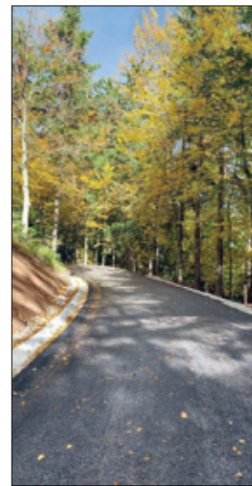
Obnova ceste na Lom
