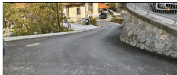
Obnova ceste na Poleni
