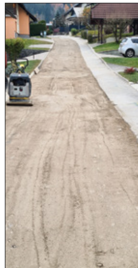
Ureditev sistema za odvajanje odpadnih vod na Stržovem
