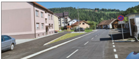
Ureditev cestišča na Prežihovi ulici
